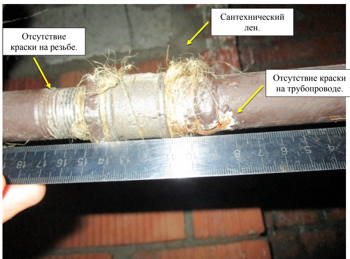
Общий вид участка трубопровода с заменённым сгоном.
