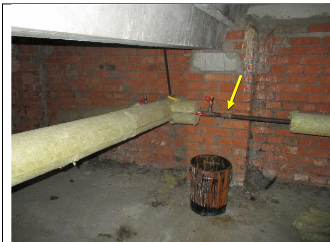
Общий вид участка трубопровода системы отопления, расположенного непосредственно над исследуемой квартирой.
